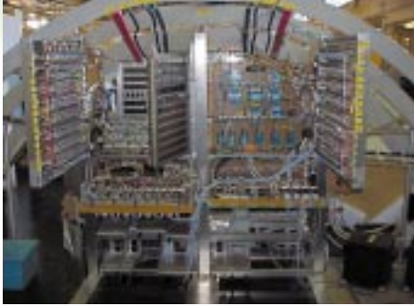
Le meuble de secours de l'A380 (2500 VU)
