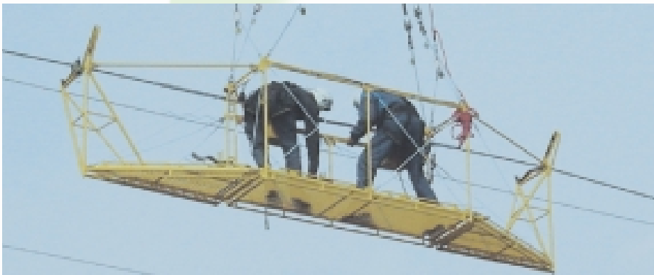
Nacelle hélicoptée pour maintenance câbles HT et THT
