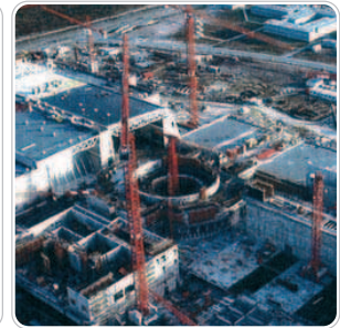
→ Le bâtiment en cours de construction → The building under construction
